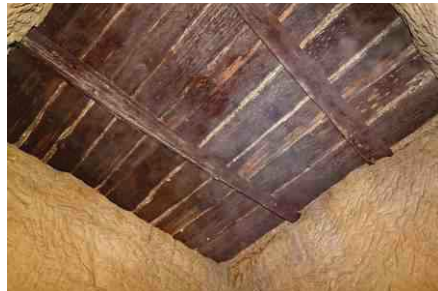
Un ancien puits d'accès au collecteur, fermé par des planches et recouvert de terre. Depuis la surface, il n'est pas possible de voir cet accès
