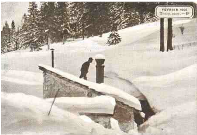
Une maisonnette obstruée par la neige à l'entrée du tunnel pour l'exploitation du ciment aux Convers
