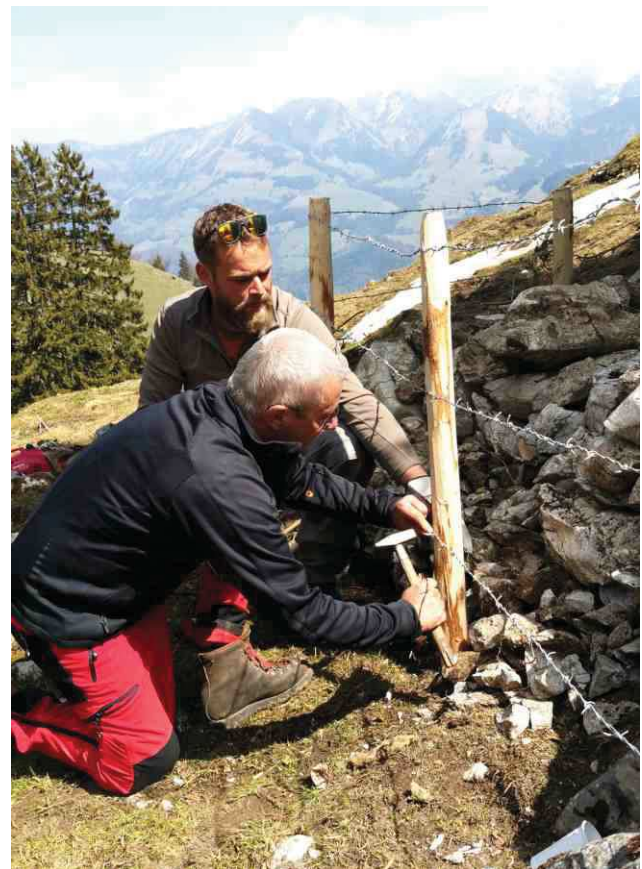
Sécurisation du puits d'entrée du Trou de la Fève : les talents conjugués des Gruyériens et des Glânois à l'œuvre (photo Roman Hapka et François Porchet)
