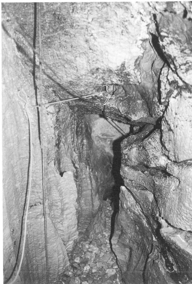
*Sumpfloch: entrée de la 6ème étroiture après le minage. Les câbles de tir et de l'alimentation électrique sont fixés sur des amarrages naturels du plafond et de la paroi au moyen de fils de fer. (photo R. Huber)*
