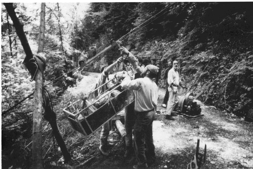
Figure 6: Le téléphérique qui a servi au transport des sacs de sédiments entre la grotte et la route, le 19 juin 1993 (Photo Rémy Wenger).
