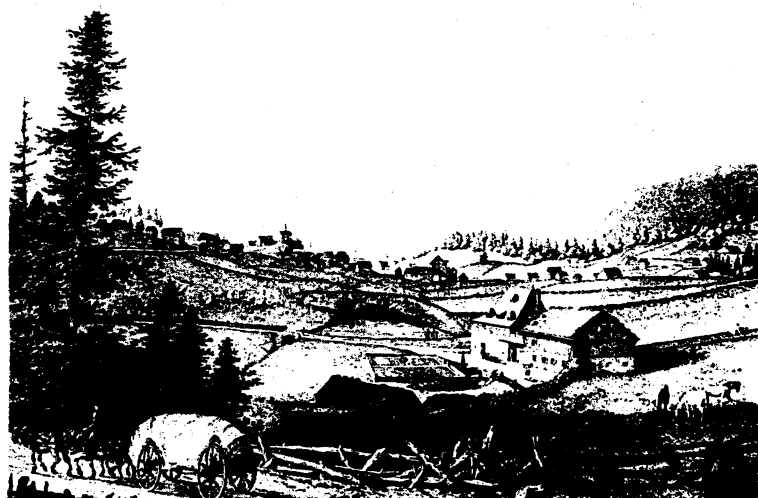
Fig. 1: La Chaux-de-Fonds et les moulins de Moïse Perret-Gentil vers 1875. Le bâtiment principal, au toit très pentu, subsiste encore. La petite maison visible à droite du chariot, dans l'ombre, est la scierie. (Tiré de COP, 1987).
