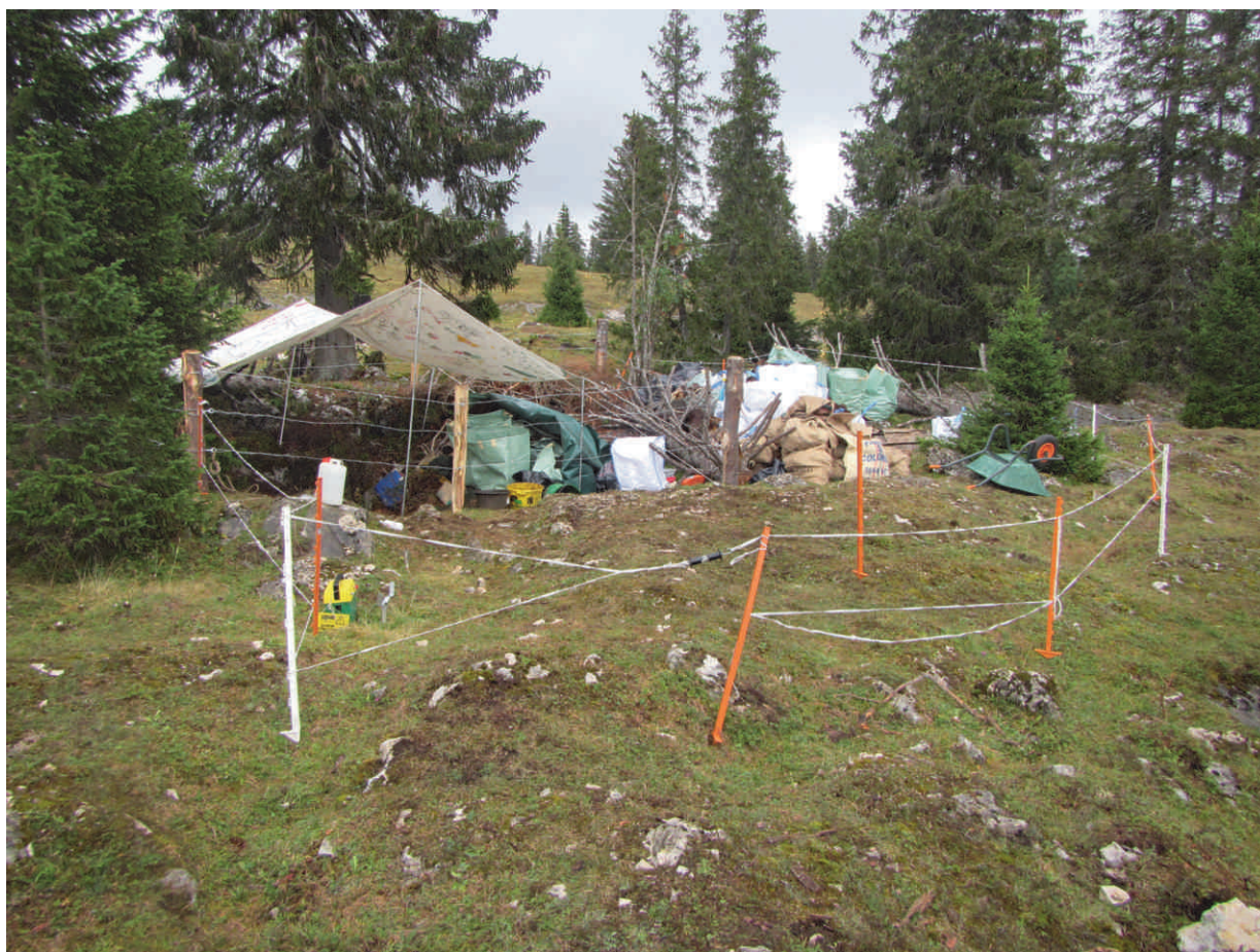
Vue générale du chantier à la fin des travaux.
