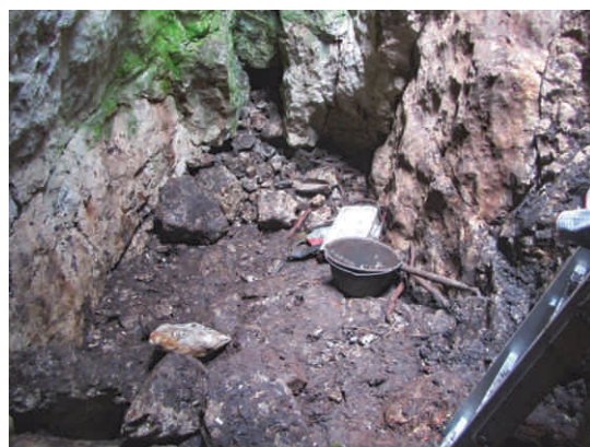
État du fond de la cavité à la fin des travaux.
