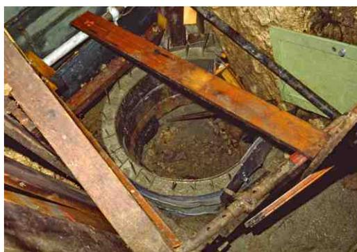
*Nous sommes descendus d'environ 2,50 mètres en utilisant un coffrage provisoire en bois, mais il était nécessaire de bétonner afin que le passage soit suffisamment sécurisé et résistant aux crues.*
