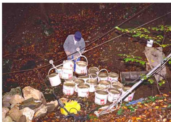
*Le béton était malaxé dans une bétonnière, chez moi à deux kilomètres, et mis dans des bidons que l'on transportait sur une remorque. On les descendait à l'entrée, on les brassait, et on déversait le béton dans un tuyau afin qu'il arrive dans le coffrage ! On utilisait de 30 à 60 seaux de béton par bétonnage !
