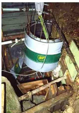
*Dans l'atelier que j'ai chez moi, j'ai fabriqué des coffrages perdus au moyen de fûts découpés. Une bande de tôle à l'intérieur, une armature à l'intérieur soudée, et une autre bande de tôle à l'extérieur.*
