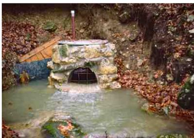
*Avec les pierres extraites lors de la désobstruction, on construit l'entrée. Une ouverture est laissée pour le passage de l'eau. Sur la photo on voit la première crue qui a lieu depuis le début de la désobstruction.*
