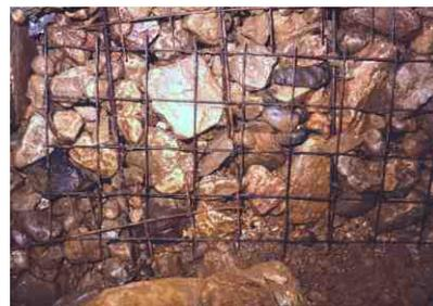
*Il était possible de creuser au maximum un mètre de profondeur à chaque étape. Après il y avait trop d'éboulements. Il était nécessaire de bétonner tout en utilisant le moins de béton possible. Pour cette raison, lors du ferrailage, je remplissais au maximum avec des cailloux derrière les fers à béton. Le béton venant par la suite consolider la structure en évitant un effet de trémie lors des creusages en dessous.*
