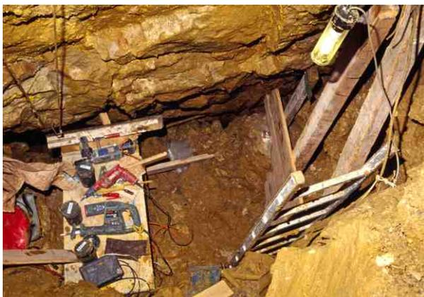
A la profondeur de -38 mètres, une zone instable nécessite un bétonnage. Un petit atelier souterrain est installé avec tous les outils et machines afin de réaliser le coffrage. L'armature est liée au rocher par des enclaves chimiques. Quand la cavité est en crue le débit atteint plus de 2 m<sup>3</sup> par seconde !
