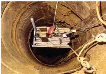
Descente de matériel pour les travaux de coffrage au moyen d'une benne conçue pour pouvoir fonctionner dans le puits de 25 mètres, ainsi que dans la suite du gouffre qui est en pente de 60 degrés. Dans cette partie le câble de guidage permet à la benne de suivre le plafond.
