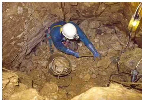
Laurent en train de creuser à une profondeur -28,5 mètres. A cet endroit, il n'est plus nécessaire de bétonner. On devine le passage de l'eau aux cailloux bien propres.
