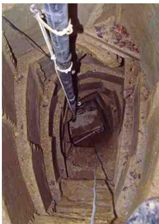
Un bétonnage permettait d'avancer d'environ 90 centimètres ! Chaque cycle de progression nécessitait 4 jours de travail :
