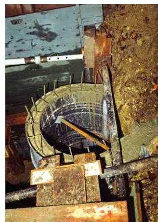
*Amenés sur place, les coffrages sont descendus au tire-fort. Des fers sont scellés dans le rocher. Le tout est bétonné.*
