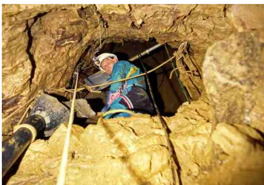
Bétonnage à la profondeur de -39 mètres. Le béton est descendu au treuil dans des bidons, brassé dans un bac puis redescendu dans un tuyau et directement déversé dans le coffrage. Le tout est vibré au moyen du vibreur à béton. Ensuite il faut tout ressortir et laver l'important matériel : tuyaux, vibreur, une trentaine de bidons, vibreur à béton, remorque, cordes, en plus du matériel spéléo normal ! Le décoffrage sera effectué 1 à 2 jours plus tard.
