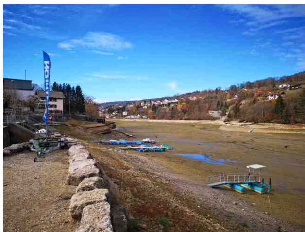
Le lac des Brenets totalement asséché le 9 novembre 2018. Seule une mince rigole constituée des eaux des STEP du Locle, des Brenets, de Morteau et Villers-le-Lac marque le lit du Doubs (photo Roman Hapka).
