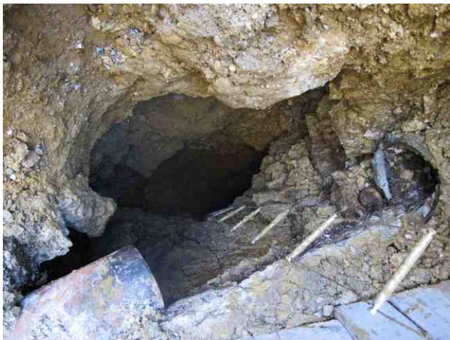
Vue depuis l'entrée de la cavité (la canalisation est visible en haut et à droite en bas)
