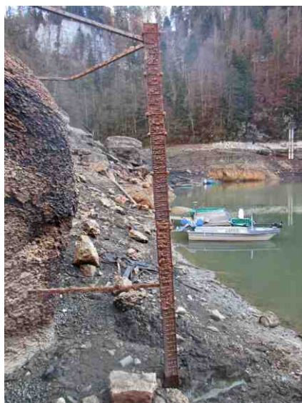
Le 22 novembre 2018, l'ancienne sonde à niveau (limnimètre) installée en 1906 au débarcadère du Saut-du-Doubs est totalement hors de l'eau (photo Alain Ballmer)
