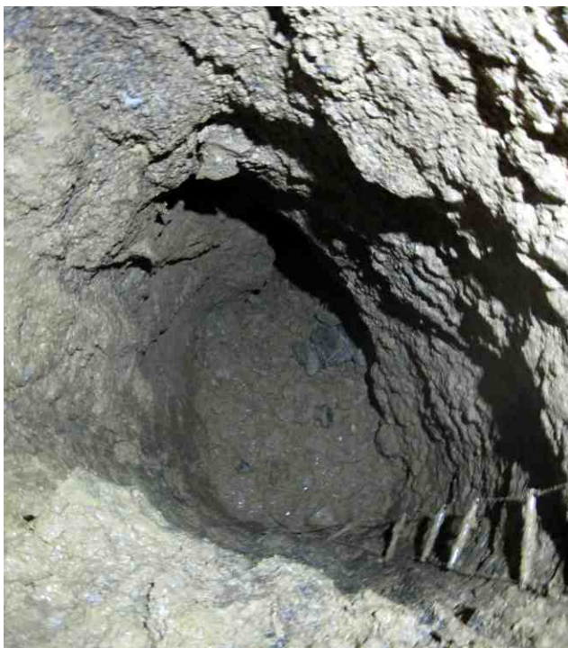
Vue vers le fond de la cavité (visée entre -6 et -9m). Les dimensions du fond sont de l'ordre de 1m de diamètre
