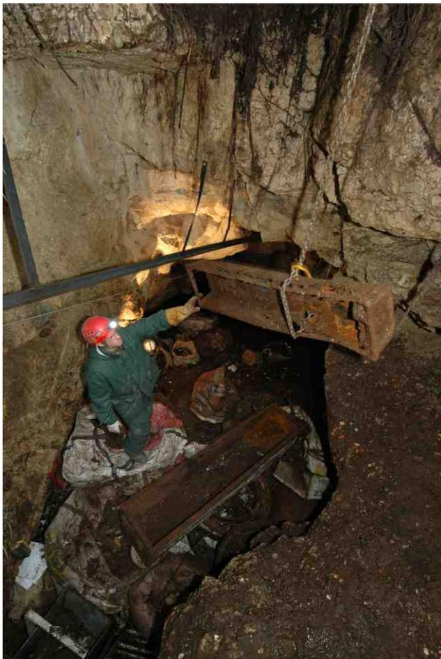
m3 de terre souillée et déchets mélangés dans le puits d'entrée. Le pilotage du grappin requiert une grande dextérité de la part du machiniste, en effet l'entrée de la cavité est relativement exigüe et tortueuse.
